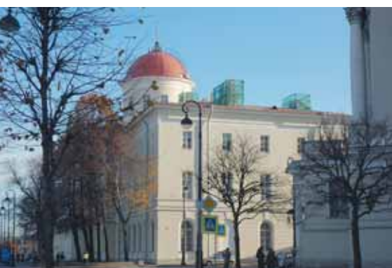
Пушкинский дом. 31.10.2015. Ремонтные работы крыши и фасада здания на момент осмотра не проводились.
