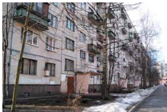
Пр. Просвещения, д. 53, корп. 3. Повторная проверка придомовой территории. Незаконных построек не выявлено. 10.03.2016.
