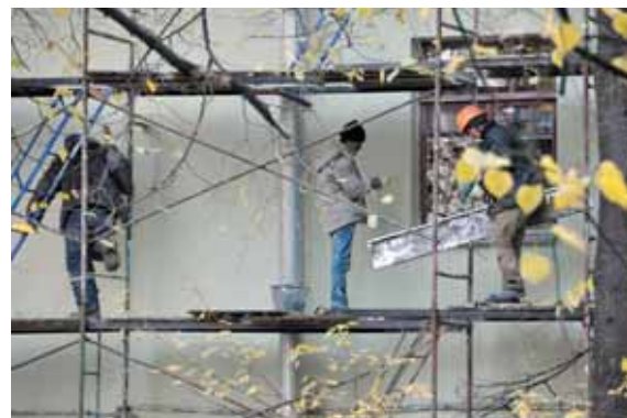
Ул. Тверская, д. 16. Иностранные работники ремонтируют фасад жилого дома.
