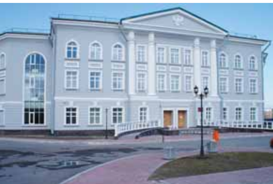
Здание Пушкинского районного суда (г. Пушкин, ул. Школьная, д. 2, корп. 2).
