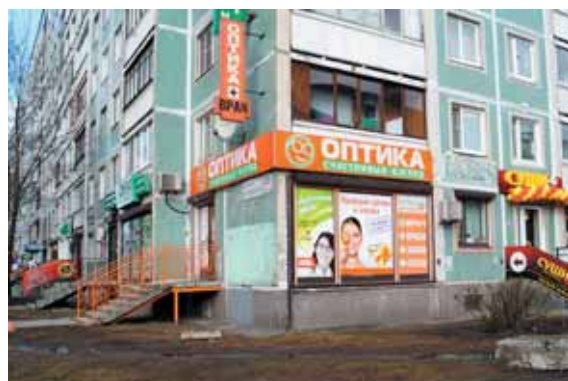
Магазины и кафе на первом этаже жилого дома (пр. Просвещения, д. 30, корп. 1).
