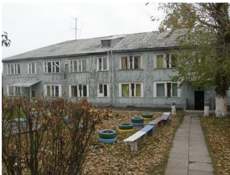
Усольская областная психоневрологическая больница размещена в деревянном здании
