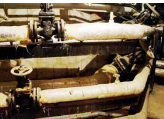
Подготовка внутридомовых теплосетей к отопительному сезону.
