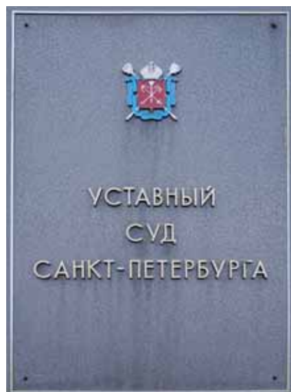
Уставный суд Санкт-Петербурга располагается в Федеральном доме на Суворовском проспекте. Вход в здание не оборудован пандусами для маломобильных групп населения.
