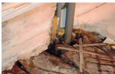
Коммунальная квартира в д. 209 на наб. Обводного канала. Осмотр перекрытий между первым и вторым этажами.
