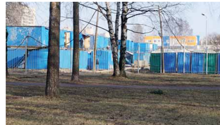
Место проживания иностранных рабочих на стройке нового здания Клинической инфекционной больницы имени С.П. Боткина, Полустрово.
