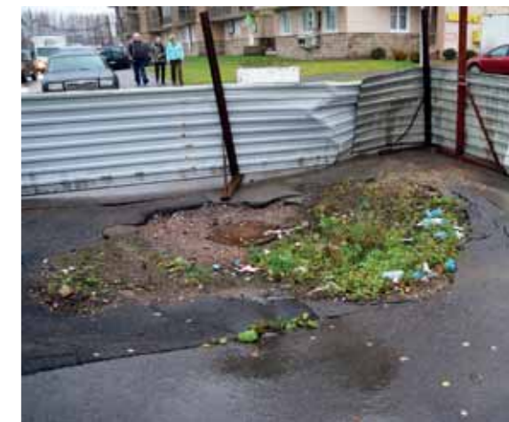
Провал грунта у канализационного коллектора в квартале «Новая Скандинавия».
