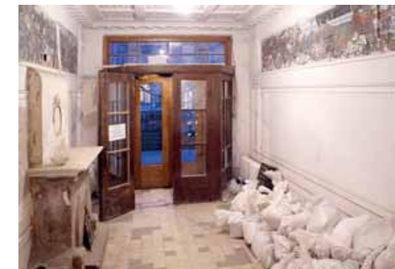
Ремонтные работы в многоквартирном доме в центре города.
