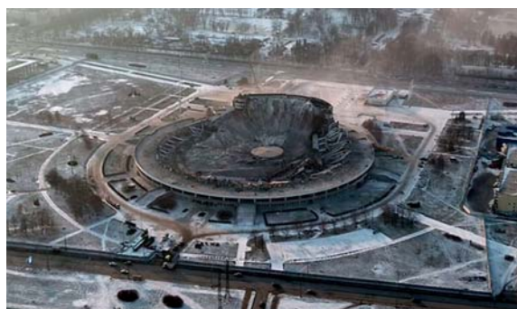
СКК после обрушения.
